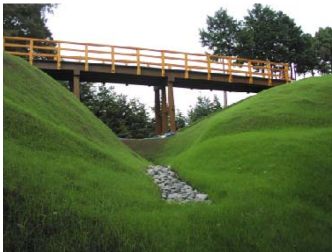
河村城跡 堀切と木橋の復元
