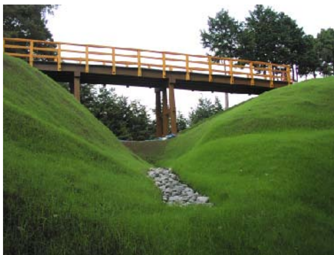
河村城跡 堀切と木橋の復元
